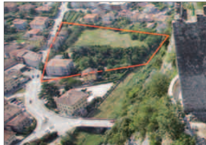
L'area di recupero di Mogno, hotel Arco (Foto Shop Professional)
